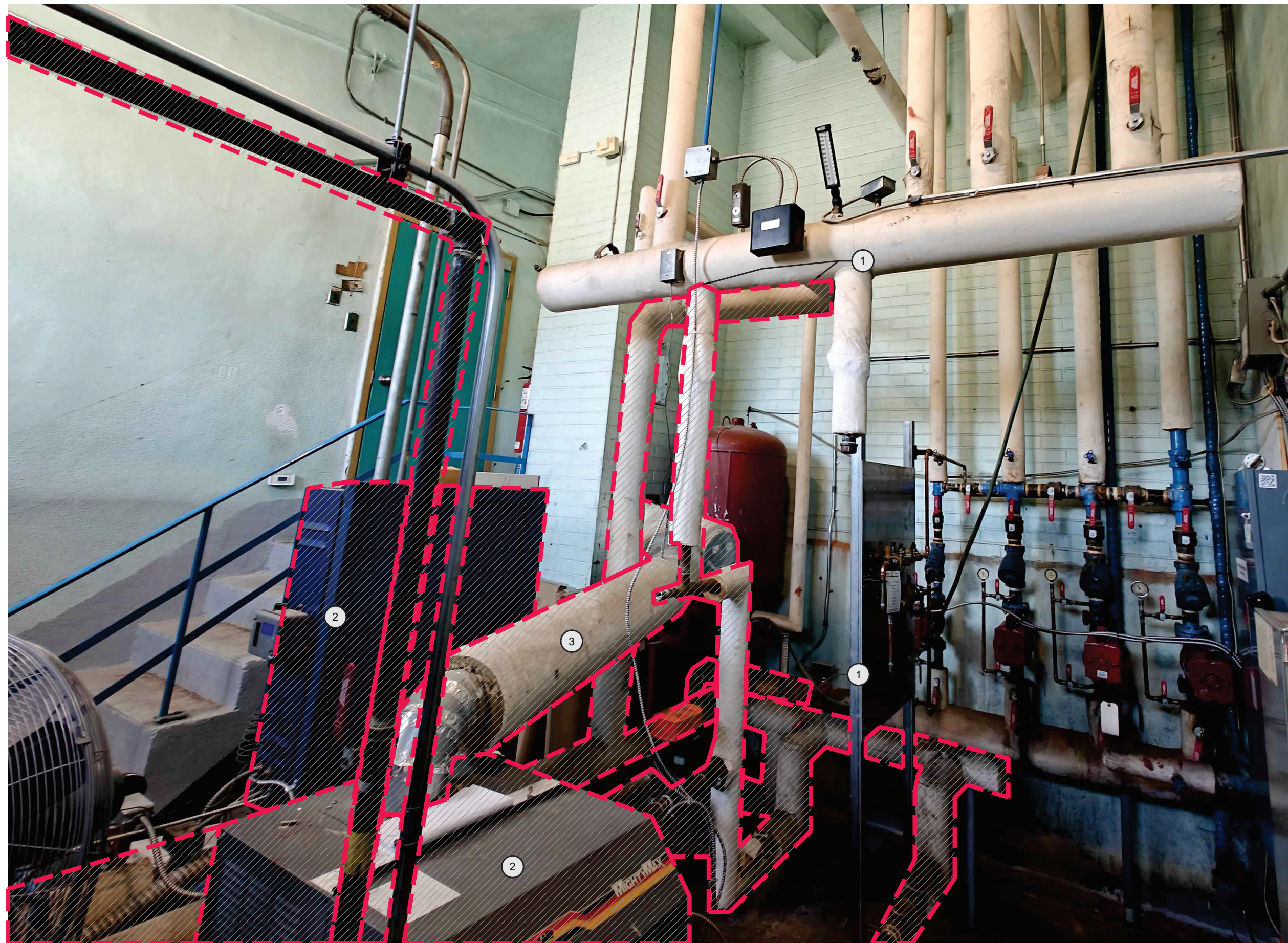
PHOTO RÉFÉRENCE A | CHAUFFAGE | DÉMOLITION ÉCHELLE: AUCUNE
