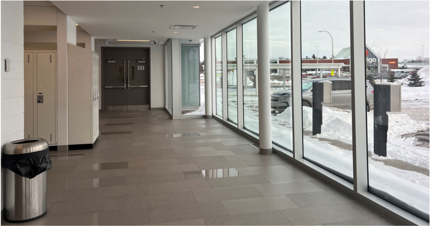
Futur emplacement de la nouvelle palestra
