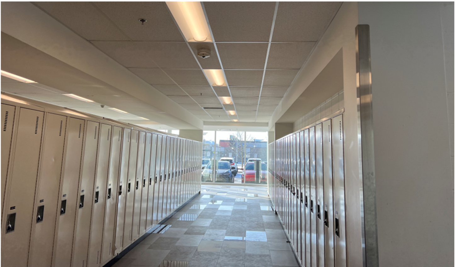
Futur emplacement de la nouvelle palestra
